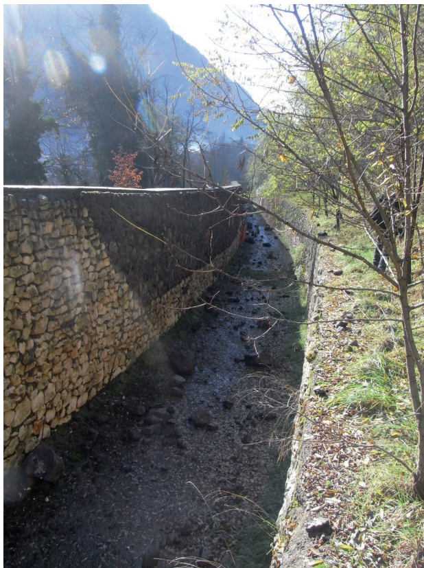
Fig. 96 - Prospettica del vallo e del tomo in muratura a difesa dell'abitato di Condino (foto R. CAMPANA, 2010).
