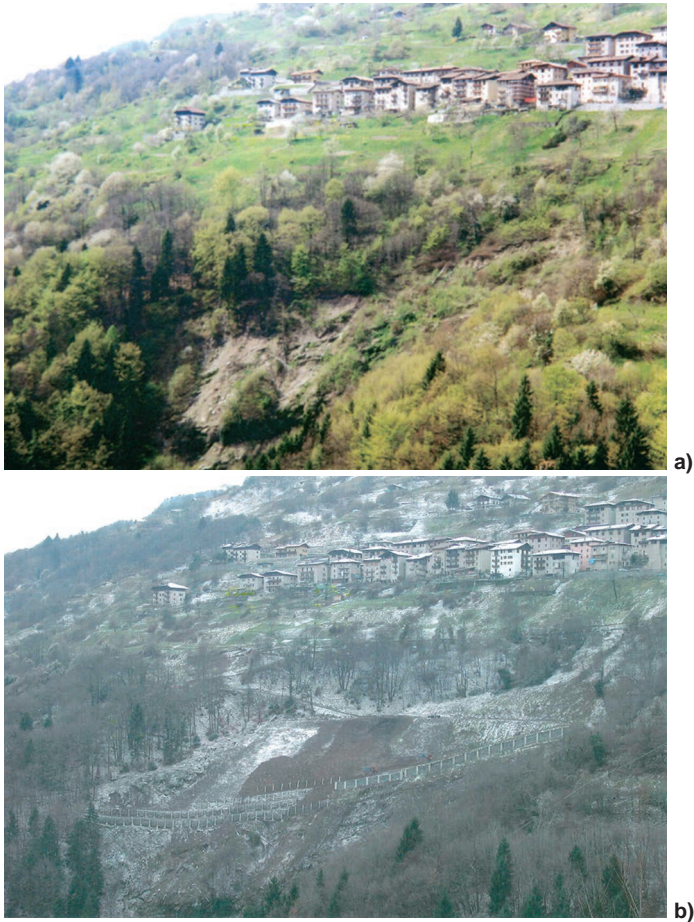
Fig. 100 - a) Immagine della frana di Castel Condino, a valle dell'abitato, subito dopo l'evento e b) in seguito al consolidamento del versante.
