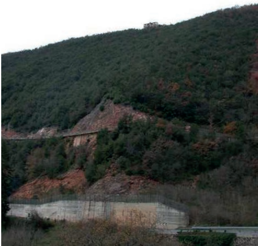
Fig. 41 - Caduta massi dalle pareti in Scagli Rossa lungo la viabilità provinciale presso Cerreto di Spoleto (autore Servizio Geologico e Sismico).
