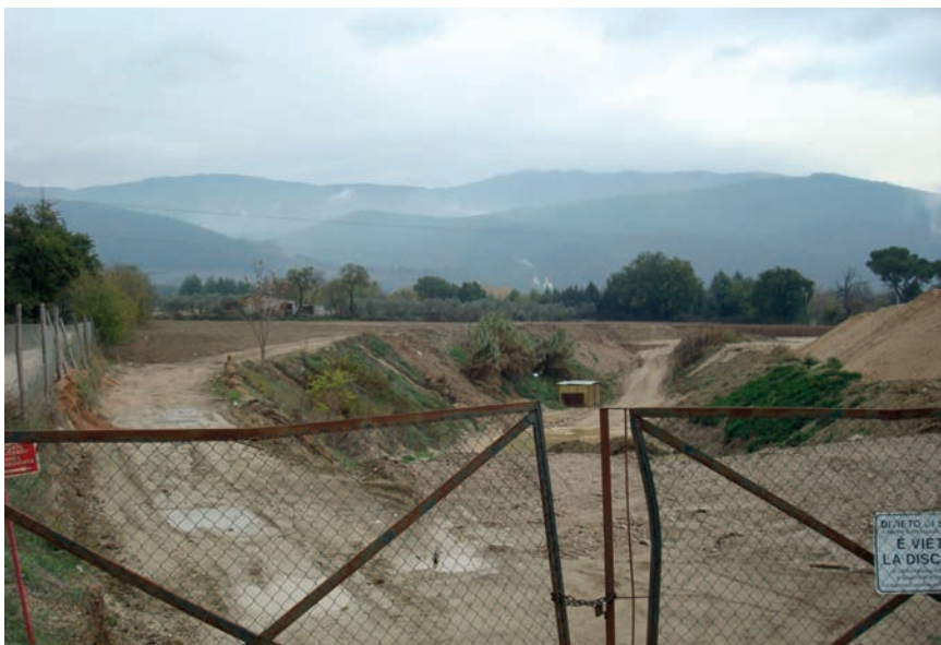
Fig. 57 - Cava di fondovalle per l'estrazione del materiale ghiaio-sabbioso quasi completamente ripristinata con la restituzione delle superfici all'uso agrario.
