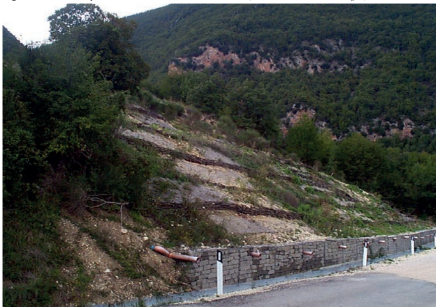
Fig. 45 - Interventi di sistemazione lungo la strada provinciale Meggianese (autore Servizio Geologico e Sismico).
