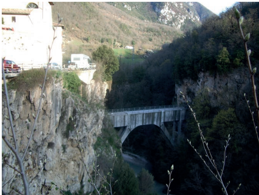
Fig. 51 - Triponzo, pareti in travertino lungo il F.Nera destabilizzate dalle scosse sismiche del 1997 (autore Donatella Frapiccini).
