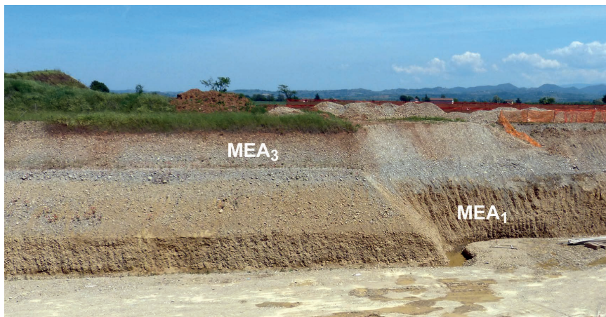
Fig. 36 - Depositi ghiaioso-sabbiosi del subsintema di Acqui ( MEA 1 ) esposti lungo la trincea dell'imbocco sud della galleria ferroviaria di Pozzolo Formigaro, un chilometro a est dell'abitato. È ben visibile il contatto con i sovrastanti depositi del subsintema di Pian del Gatto ( MEA 3 ).
