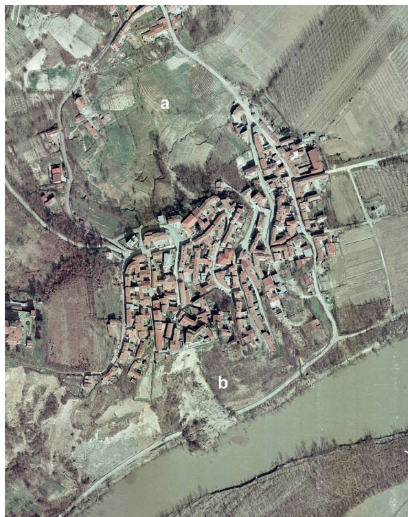
Fig. 73 - Ripresa aerofotografica dello sperone di Montecastello in cui si osservano gli effetti dell'evento alluvionale del marzo 1978. Nella parte alta dell'immagine (a) è ben evidente la grande frana a cinematismo complesso che ha coinvolto il settore di versante a nord dell'abitato, mentre nella parte bassa (b) è visibile l'accumulo della frana che il 9 marzo ha parzialmente invaso l'alveo del F. Tanaro.
